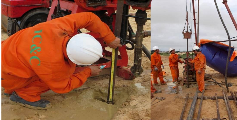
Hình 5: Thí nghiệm SPT/ Figure 5: SPT test
