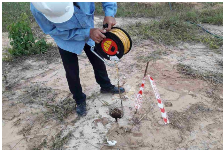
Hình 6: Quan trắc mực nước ngầm/ Figure 6: Monitoring ground water level
