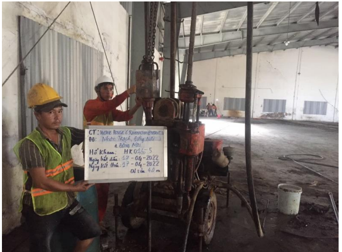
(Hình 1: Máy khoan khảo sát địa chất)
