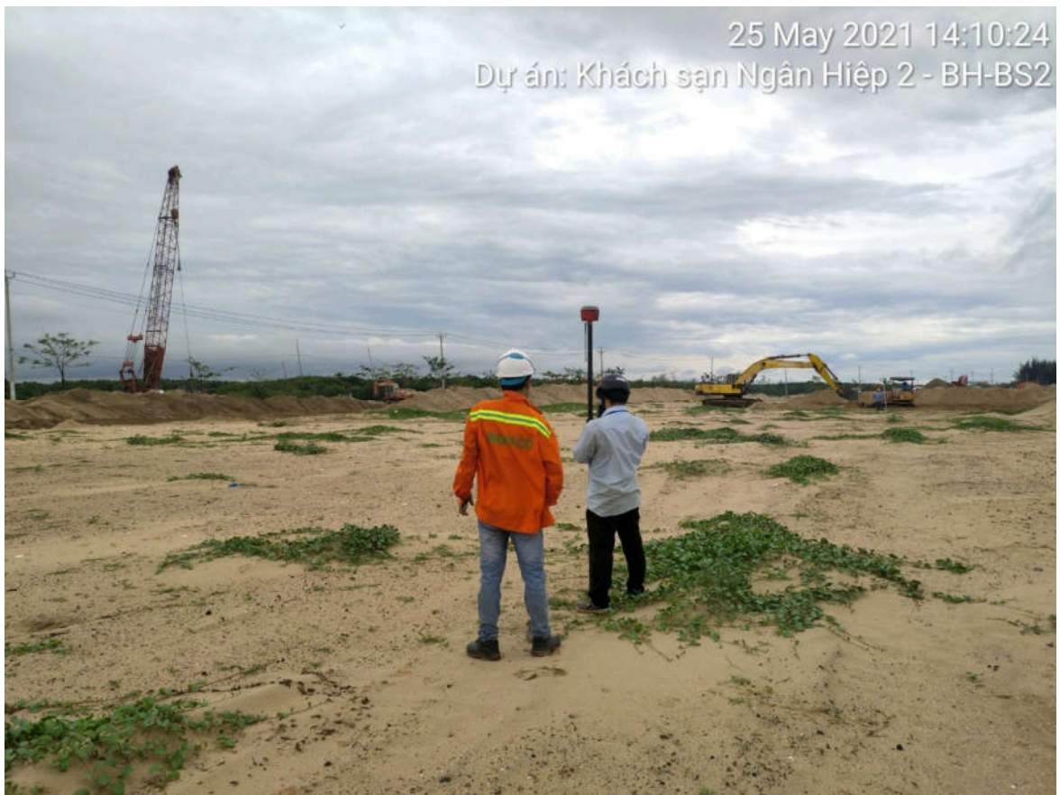
Hình 2: Công tác xác định tọa độ bằng máy Omnistar 5120 VBS DGPS
